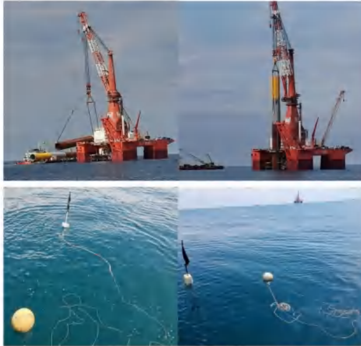
图 3.4-1 湛江徐闻海上风电场单桩基础承台打桩水下噪声监测
